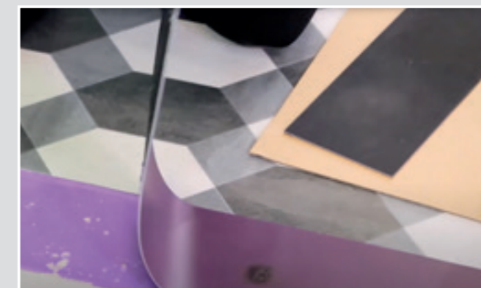
Falls nötig, können einzelne Planken auch lange nach der Verlegung, ausgetauscht werden.
