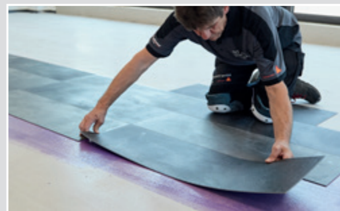
Dank der 2-stündigen Einlegezeit ist es möglich große Flächen in einem Zug zu bearbeiten.
