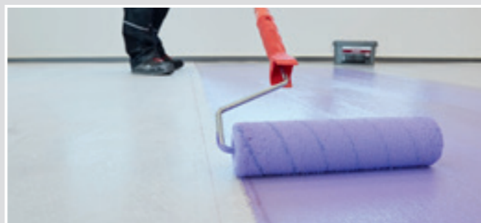
SCHÖNOX iFLOOR® wird im Stehen mit einer Rolle aufgetragen.
