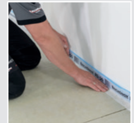
5 SCHÖNOX RS 50 zu allen aufgehenden Bauteilen anstellen.
