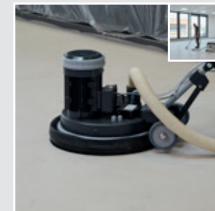
7 Das Schleifen und anschließende Absaugen zur Reinigung dient zur Entfernung von leichten Oberflächenstörungen.
