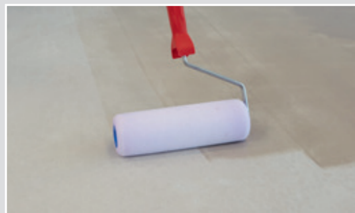
Systemkomponente SCHÖNOX KH FIX - die Grundierung ist gebrauchsfertig und schnell trocknend.
