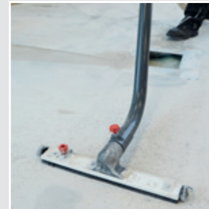
1 Den Untergrund zur Vorbereitung gründlich schleifen und absaugen.
