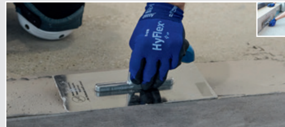
4 Ausbrüche und Anrampungen mit SCHÖNOX HS 40 S bearbeiten.
